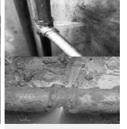
Yangın Sprinkleri Sistemi
